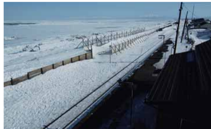
駅から流水を見ることができる北浜駅 (北海道)
